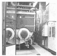
Energiezentrale: links der Dampfkessel; rechts im Schallschutzgehäuse die Gasturbine mit Schaltschrank
