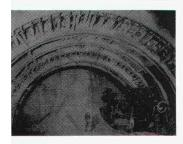
Im Tunnelbau ist der Ingenieur oft mit wechselnden geotechnischen Verhältnissen konfrontiert. Von Vorteil sind dann flexible Vortriebsmethoden, insbesondere geeignete Massnahmen zur Vorauskonsolidierung im Brust- und Kalottenbereich.
