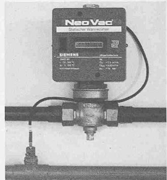
zung; keine Beschädigung, auch nicht bei mehrfacher Überlastung; Anschluss-Stück (Pass-Stück) ist absperrbar, keine Absperr-Armaturen vor und nach dem Zähler mehr nötig; unabhängig von einer Netzstromversorgung, mit 6-Jahres-Batterie; Nur 0,1 bar Druckabfall bei Nenndurchfluss; Maskenprogrammierter Mikrocomputer in CMOS-Technik und mit manipulationssicherer Flüssigkristallanzeige; lichtgesteuerte Umschaltung der Anzeige.
