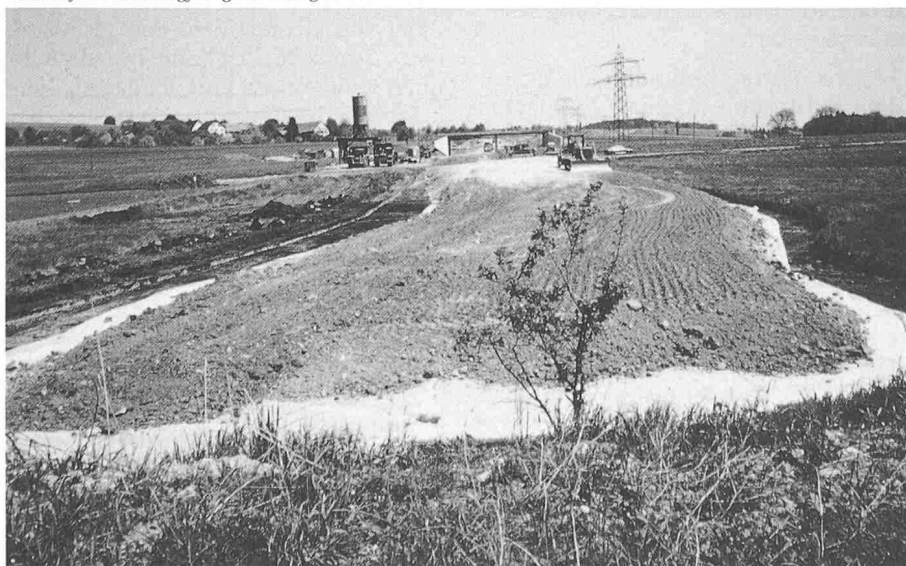
Bild 4. Bändchengewebe eingesetzt für Baupiste für Nordumfahrung Zürich N20 auf schlecht tragfähigem Untergrund
