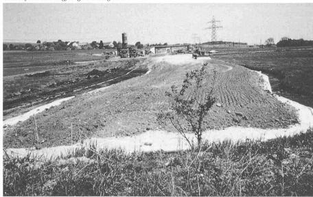
Bild 5. Bändchengewebe eingesetzt im Güterstrassenbau im Kanton Glarus
