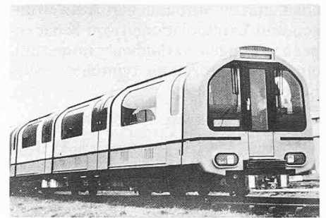
Prototypzug für die Central Line der Londoner U-Bahn. Brown Boveri hat diesen von Metro Cammell gebauten Zug mit modernsten GTO-Chopper-Antrieben ausgerüstet (BBC-Foto)
