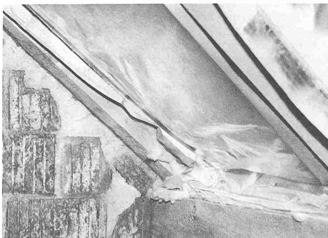
Bild 3. Nicht luftdichte Anschlüsse bei Sparren und Schwelle
