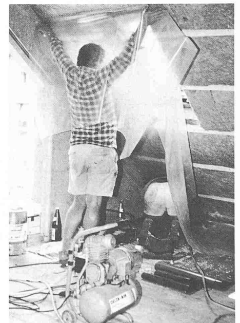
Bild 8. Der Einbau grossflächiger Luftdichtungsschicht, zusätzliche Wärmedämmschicht an Sparrenunterseite
