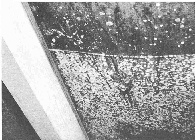
Bild 2. Pilzbildung am Unterdach
