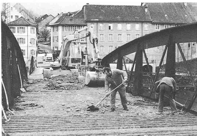
Bild 3. Entfernen von Chaussierung und Belag der Zoresisenfahrbahn 1984. Im Hintergrund die Altstadt von Kaiserstuhl mit dem Engpass beim Zoll
