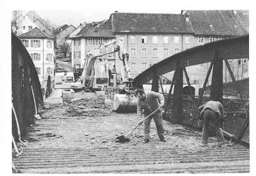
Bild 3. Entfernen von Chaussierung und Belag der Zoreseisenfahrbahn 1984. Im Hintergrund die Altstadt von Kaiserstuhl mit dem Engpass beim Zoll
