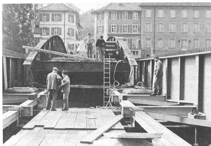
Bild 9. Abbruch der alten Fachwerkbrücke. Die neuen, mit Montageverbänden und Querriegeln ausgesteiften Vollwandträger dienen als Gerüst
