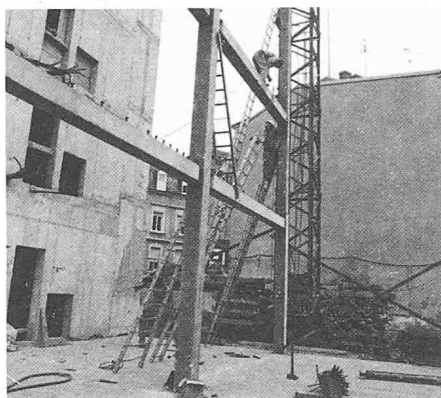
Bild 6. Dachstuhl in Stahlbauweise
