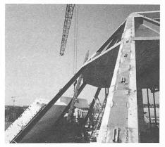
Bild 7. Montage einer Stütze
