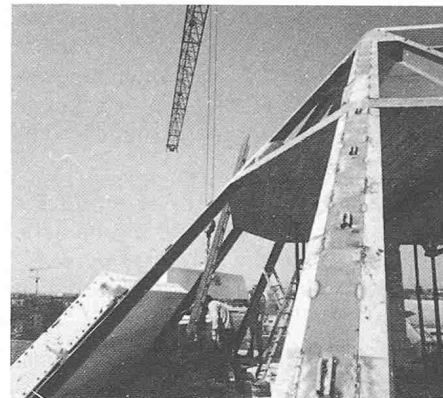
Bild 7. Montage einer Stütze
