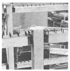
Bild 2 AF-Stahlverbundstützenelement
