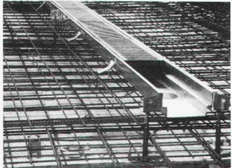
Das ist die neue BRODER-Parkingrinne für den Direkteinbau mit der klaren technischen Überlegenheit der Höhen- und Gefällsnivellierung. Einbauhöhe ab 50 mm.
