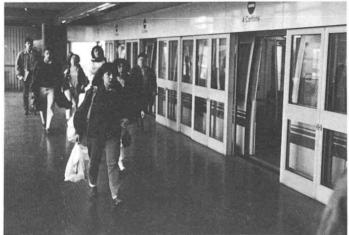
Bild 5. Der Bahnsteig ist vollständig vom Lichtraumprofil der Métro abgetrennt. Zugang zu den Fahrzeugen besteht nur an vorgegebenen Stellen, wobei sich die Bahnsteig- und Fahrzeurtüren gleichzeitig öffnen und schliessen – im Prinzip wie bei einem Lift. (Bild: Verfasser)
