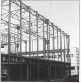
Die elegante 330-Tonnen-Stahlkonstruktion mit den Grundmassen von 36 x 65 Metern ruht auf 30 Hauptstützen aus dickwandigen Siederohren mit abgestuften Wandstärken. Sie sind in beiden Achsen biegesteif an die schweren Wabenträger des Zwischenbodens und an das leichte Fachwerk des Daches angeschlossen. Ästhetik prägt sich hier als Funktion hoher Nutzlast aus.
