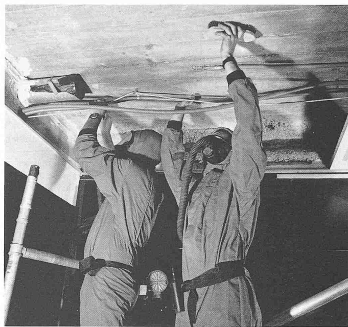
Bild 2. Zum Entfernen des Spritzasbests wird der Raum vollständig mit Kunststofffolien ausgekleidet und gegenüber der Umgebung auf Unterdruck gesetzt. Der Sanierende ist durch Schutzanzug und Vollgesichtsmaske mit Schwebstofffilter von der staubhaltigen Atmosphäre abgeschirmt.
