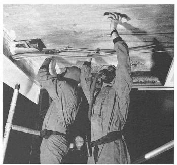
Bild 2. Zum Entfernen des Spritzasbests wird der Raum vollständig mit Kunststoffolien ausgekleidet und gegenüber der Umgebung auf Unterdruck gesetzt. Der Sanierende ist durch Schutzanzug und Vollgesichtsmaske mit Schwebstoff filter von der staubhaltigen Atmosphäre abgeschirmt.
