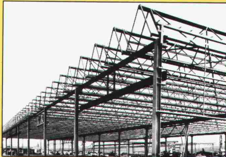
Metallstruktur eines Fabrikgebäudes mit Mini-Sheddach
