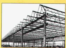
Metallstruktur eines Fabrikgebäudes mit Mini-Sheddach
