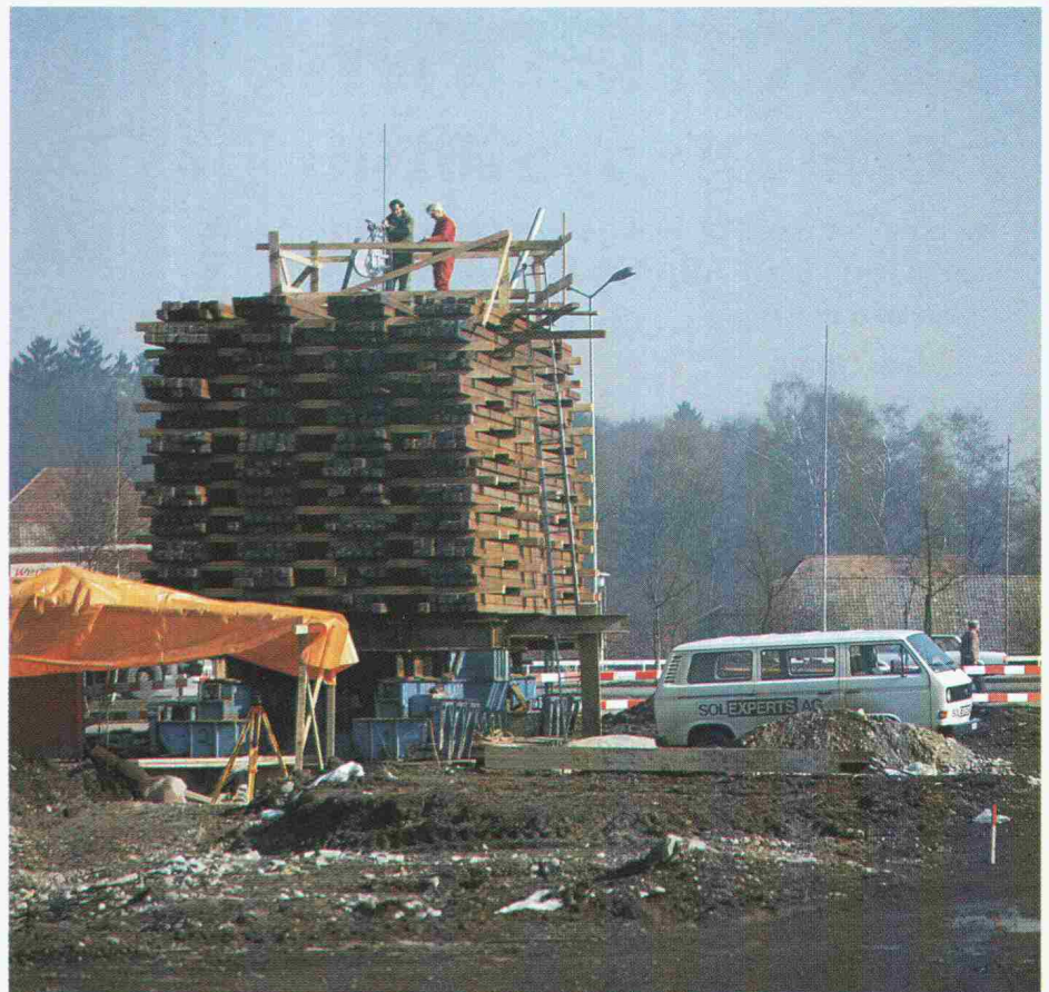
Pfahlbelastungsversuch Viadukt Neugut
