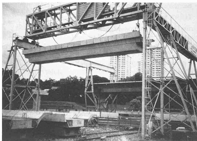
Bild 17. MRT Singapur: Heben eines 165 t schweren Spannbetonkastenträgers
