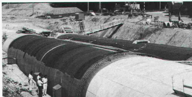
Tunnel Rathausen der N14 zwischen Luzern und Gisikon: abgedichtet mit 28 000 m 2 Sarnafil Typ GN.
