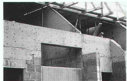
dämmung mit Styrodur:
