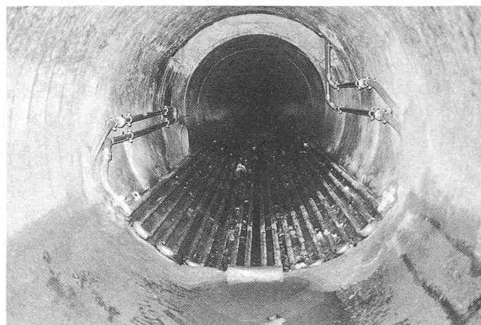
Photo 6. Echangeur de chaleur dans les égouts / Wärmetauscher im Abwasser
