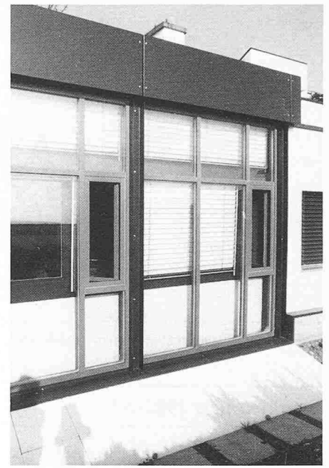
Bild 7. Die Chamäleonfassade weiss, auf Reflexion eingestellt
