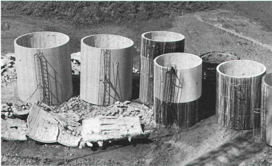
Die auf den Boden herunter gehieften Kaminelemente werden für den Abtransport verkleinert.
