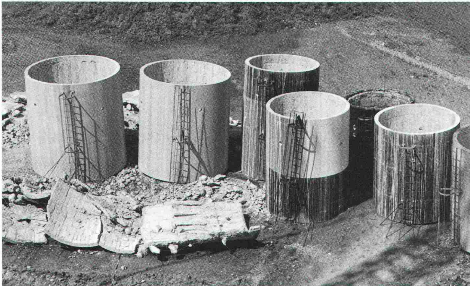
Die auf den Boden herunter gehievten Kaminelemente werden für den Abtransport verkleinert.
