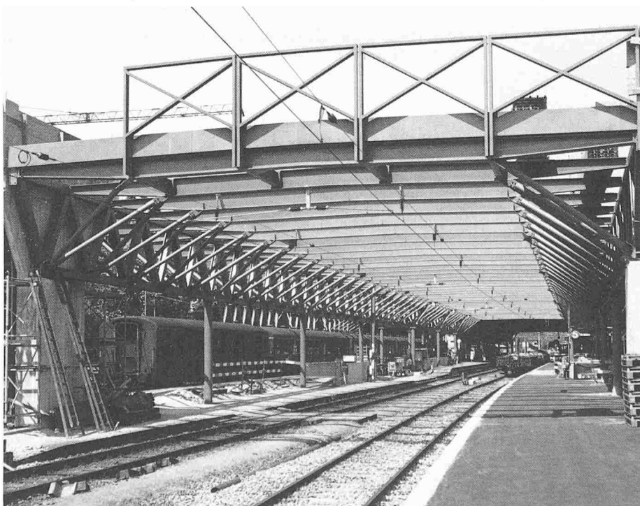
Bild 5. Überdeckung der Perronanlagen im Bau
