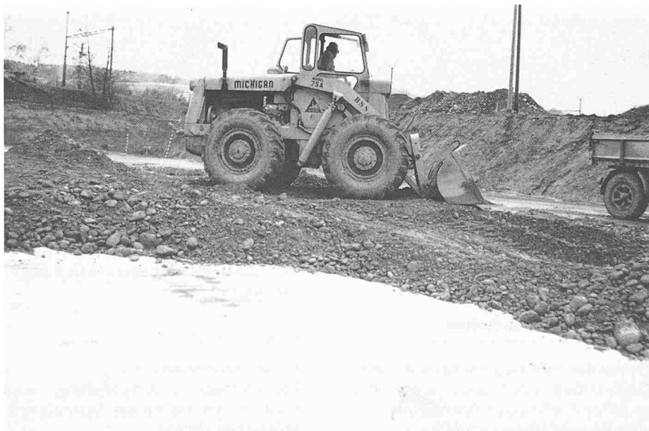
Bild 10. Geotextilien im Strassenbau. Hier kann das Geotextil eine Mehrfachfunktion erfüllen: Trennen, Filtern, Drainieren und Verstärken. Das Geotextil sollte mit schweren Baugeräten und Lastwagen möglichst nicht direkt befahren werden; eine «Vor-Kopf-Schüttung» ist erforderlich
