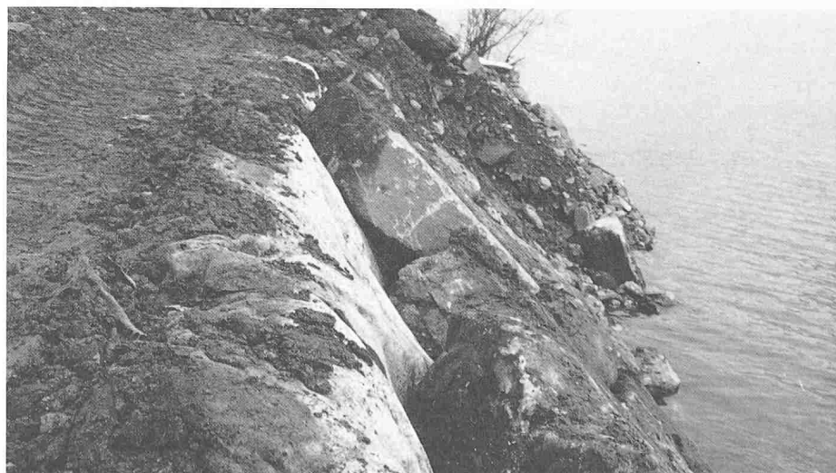
Bild 1. Geotextilien im Wasserbau: Das Geotextil kann als Trenn-, Filter- und Schutzschicht dienen. Es bietet auch einer Bepflanzung Halt und schützt vor Ausschwemmung durch Wellenschlag
