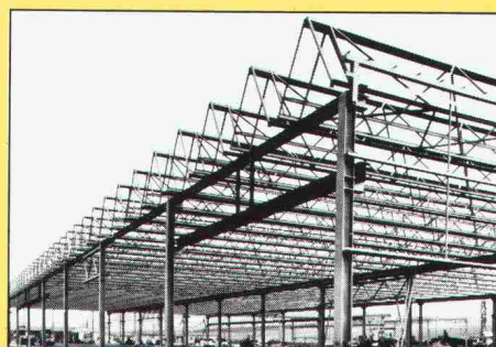
Metallstruktur eines Fabrikgebäudes mit Mini-Sheddach
