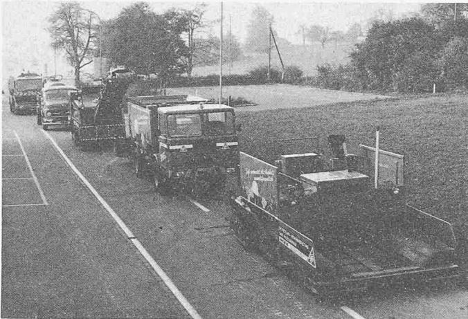
Strassensanierungs-Maschinen: Kaltrecycler, Kaltmikromaschine, Hochleistungs-Kaltfräse, Hochdruck-Waschmaschine, Saug-Wisch-Maschine.
