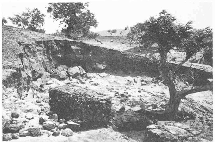
Fig. 2. Val Magia (Niger, 1985): ouvrages en gabion emportés par torrent
