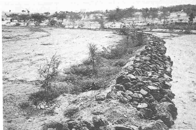
Fig. 4. Keita (Niger, 1985): murs anti-érosifs, plantation (DRS) et enverdissement naturel
