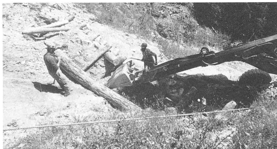
Fig. 4. Remplissage des caissons
