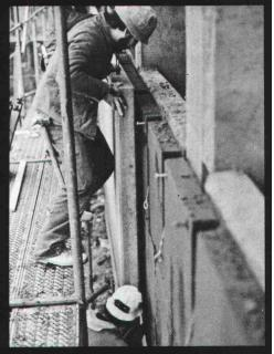
Hinterlüftete Fassaden mit offenfugigen, vorgehängten Elementen:
