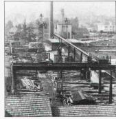
Sowohl Konstruktion als auch Montage der 150 Meter langen geschweissten Blechträger im Abstand von 26 Metern hatten sich verschiedenen Gegebenheiten anzupassen: den Gebäuden, Einrichtungen, Gruben, aber auch dem Betriebsablauf. Somit konnten gerade bei diesem nicht alltäglichen Projekt die Vorteile des Stahlbaus - Flexibilität, kleines Eigengewicht und kurze Bauzeit - bestens ausgeschöpft werden.
