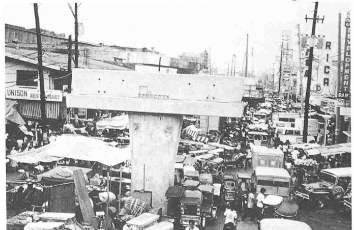
Bild 6. Aus dem Fundament wachsen die Pfeiler mit den Querträgern, Lichtraumprofil 4,5 m Höhe
