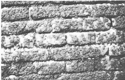
Vor Aufbringen des Anspritzes etwaige Untergrundvorbehandlung, wie z. B. Ausgleichen grösserer Unebenheiten mit entsprechendem Material, Verfestigung, Salzbehandlung vorsehen. Anspritz mit der Kelle aufbringen.
