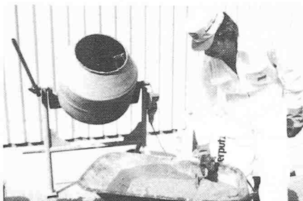
Sanierputze können mit allen bauüblichen Freifall- und Zwangsmischern gemischt werden. Mischzeit 3 bis 5 Minuten. Putzleisten mit Sanierputz herstellen.
