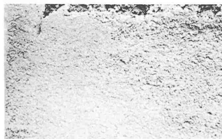
Sanierputze sind Grob- und Feinputze. Als Grobputz mit angefeuchtem Holz- oder Alulatte abziehen, als Feinputz mit entsprechendem Reibbrett verreiben. Sanierputze mindestens 2 Tage feucht halten.
