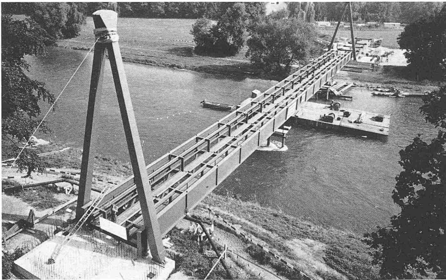
Bild 3. Der eingeschobene Versteifungsträger ruht noch auf provisorischen Jochen in der Limmat
