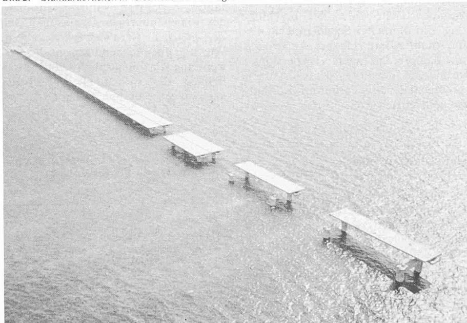
Bild 2. Standardbrücken in verschiedenen Montagestadien
