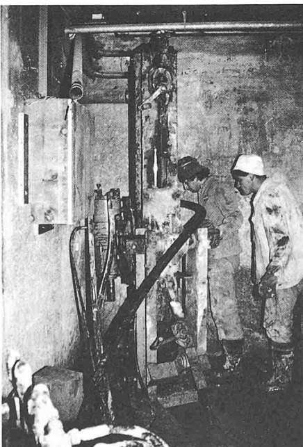
Bild 5. Einsatz der Mikropfahmaschine im Kellerraum
