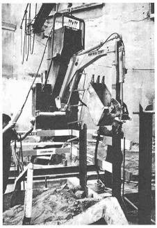
möglichte es, während der einwöchigen programmierten Stillegung des Trambetriebes infolge Umbau am Bellevue und Heimplatz, die zehn 18 m langen Rühlwandträger HEB 400 in die gebohrten Löcher zu versetzen. Die Lärmbelästigungen der ursprünglich vorgesehenen länger dauernden Spundwandarbeiten, die im übrigen in der Nacht hätten erfolgen müssen, konnten dadurch vermieden werden.
