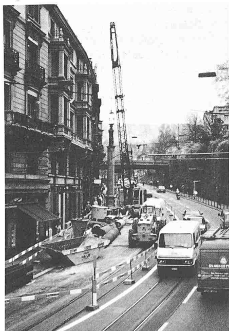
Bild 11. Erstellung der Bohrungen für Rühlwandträger
