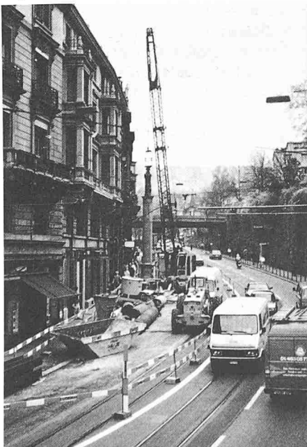
Bild 11. Erstellung der Bohrungen für Rühlwand-träger
