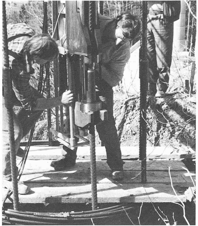
Bild 3. Verpressen des Muffenstosses. Die Presse wird von der Seite her aufgesetzt
