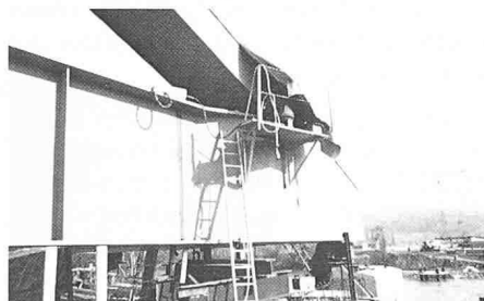
Bild 2. Montage der Aufhängungen und Querträger
