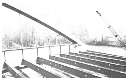
Bild 2. Montage der Aufhängungen und Querträger
