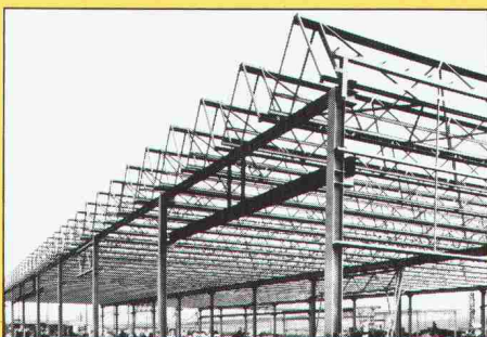
Metallstruktur eines Fabrikgebäudes mit Mini-Sheddach
