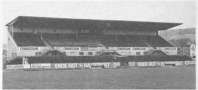
Bild 1. Tribüne der Sportanlage Schützenwiese in Winterthur
