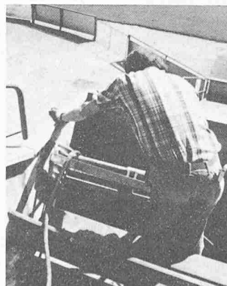
Bild 3. Kernbohrungen werden an 37 kritischen und wichtigen Stellen ausgeführt. Sie umfassen alle Schichten der Konstruktion
