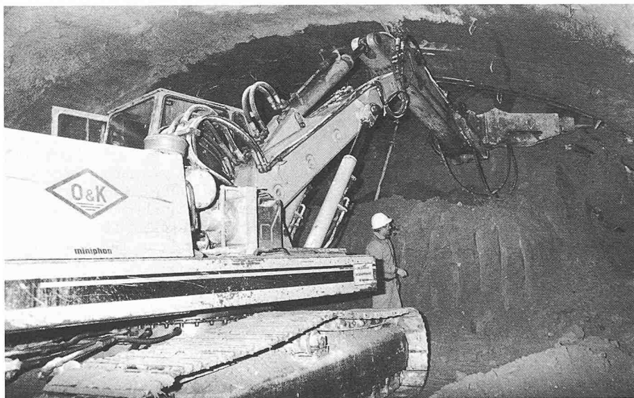
Bild 3. Tunnel Rämistrasse. Ausbruch unter dem Gefrierkörper
