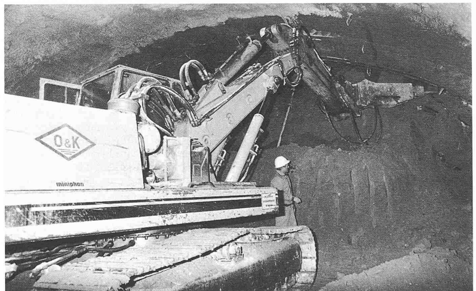
Bild 3. Tunnel Rämistrasse. Ausbruch unter dem Gefrierkörper
