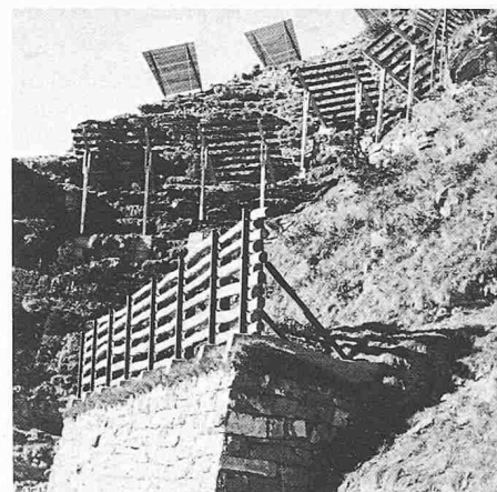
Lawinenverbauungs- und Aufforstungsprojekt Niesen. Beispiel für Entwicklung der Werktypen: 30er Jahre Trockenmauern aus am Ort gewonnenen Steinen; 40er/50er Jahre Erhöhung mit Schneehag aus Eisenbahnschienen und Holzdruckrost (unten); ab 60er Jahre Schneebrücken aus Stahl (mitte); Kolktafeln zur Vermeidung der Gwächtenbildung (Foto: W. Schwarz)
