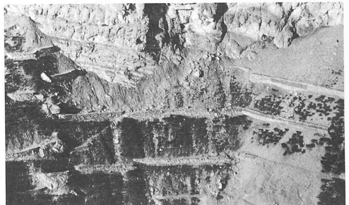
Links: Aufforstungs- und Verbauungsprojekte Urseren, Brienz (links) und Glyssibach (Bauherrschaft beider Projekte: Staat Bern). Urseren, Lawinerverbau: Kolktafeln zwischen den Bäumen auf dem Kamm zur Verhinderung der Gwächtenbildung, Stahl-Schneebrücken Voest-Alpine, Betonmauern und Schneenetze in Runsen mit Wasserabfluss. Glyssibach, Terrainverbau: Mauerterrassen (aufeinandergeschichtete Steinkisten und Steinkörbe) zur Beruhigung der Erosion, Aufforstung und Begrünung zwischen den Mauern (Foto: J. Chevalier)
