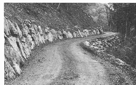
Wychelfluhweg ob Brienz. Dem Gelände angelegter Verlauf, Blöcke in Beton verlegt. Foto: FIO
