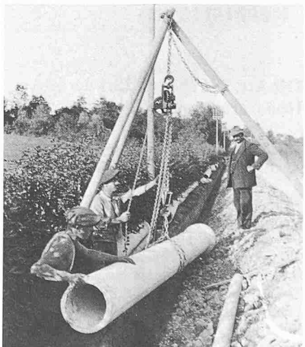
Bild 4. Verlegung des Betonrohrs für Telefonleitungen als Arbeitsbeschaffung 1921-1924
