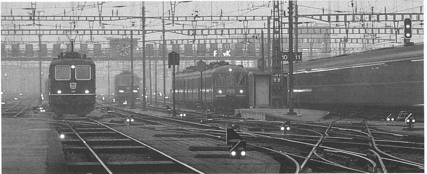
Die Kapazität des Netzes genügt dem Bedarf nicht mehr. Häufigere Fahrgelegenheiten machen die Bahn attraktiv; ihre Vermehrung kann beträchtliche Ausbauarbeiten erfordern
