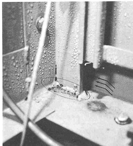
Bild 6. Kondenswasserbildung und Verschimmelung im Fussrahmen eines Apparateschranks
