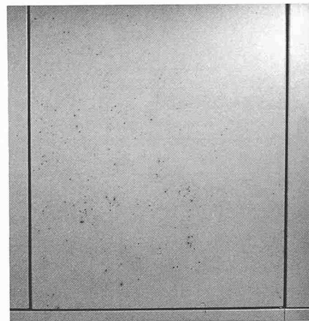
Bild 10. Punktuelle Durchrostung
