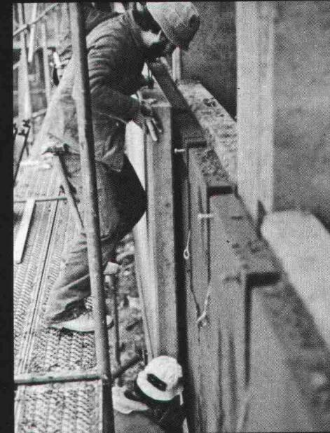
**Hinterlüftete Fassaden mit offenfugigen, vorgehängten Elementen:**
