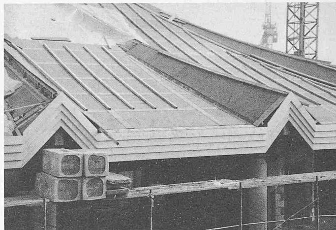
einem dünnen Schutzfilm aus Bitumenemulsion überzogen wird. Es werden nur Emulsionen von reinem Bitumen verwendet und keinerlei teerhaltige Derivate. Die Bituminierung verleiht der Platte nicht nur eine besondere Widerstandsfähigkeit gegen Feuchtigkeit, sondern auch eine hohe Festigkeit und macht sie gut begehbar und trittsicher. Isoroof-Unterdachplatten haben ein hohes Porenvolume. Sie vereinen deshalb her-
