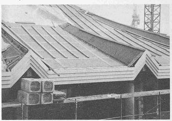
einem dünnen Schutzfilm aus Bitumenemulsion überzogen wird. Es werden nur Emulsionen von reinem Bitumen verwendet und keinerlei teerhaltige Derivate. Die Bituminierung verleiht der Platte nicht nur eine besondere Widerstandsfähigkeit gegen Feuchtigkeit, sondern auch eine hohe Festigkeit und macht sie gut begehbar und trittsicher. Isoroof-Unterdachplatten haben ein hohes Porenvolumen. Sie vereinen deshalb her-
