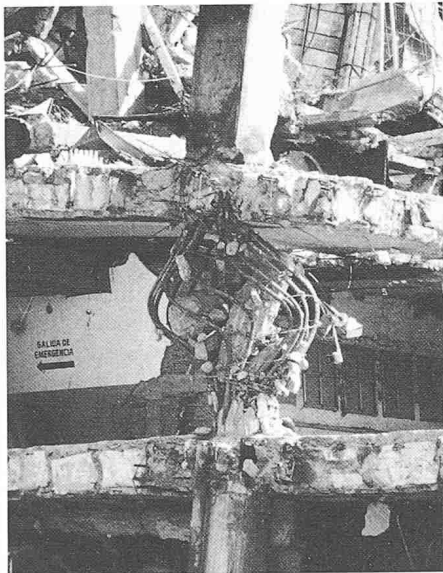
Bild 17. Versagen einer Stahlbetonstütze: Zerstörtes Betongefüge und Ausknicken der Längsbewehrung infolge ungenügender Umschnürung durch Bügel
