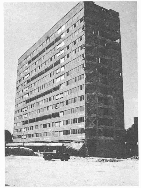
Bild 13. Stahlbetonskelett-Gebäude mit Aussteifungen mittels Stahlbetondagonalen (ein analoges, direkt anschliessendes Gebäude stürzte ein, vgl. Bild 1a, Tlatelolco-Bezirk)
