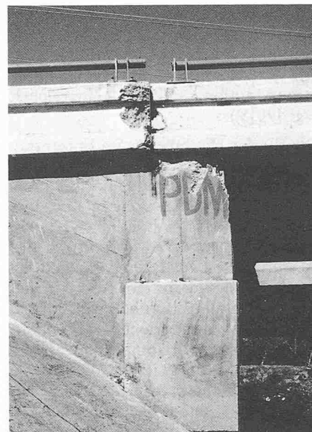
Bild 11. Schäden an einer Brücke über den Rio Balsas bei Lazero Cardenas: Aufprall des Brückenträgers auf das Widerlager
