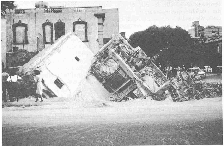
Bild 22. Dieses Gebäude kippte infolge Versagens der Reibungspfähle
