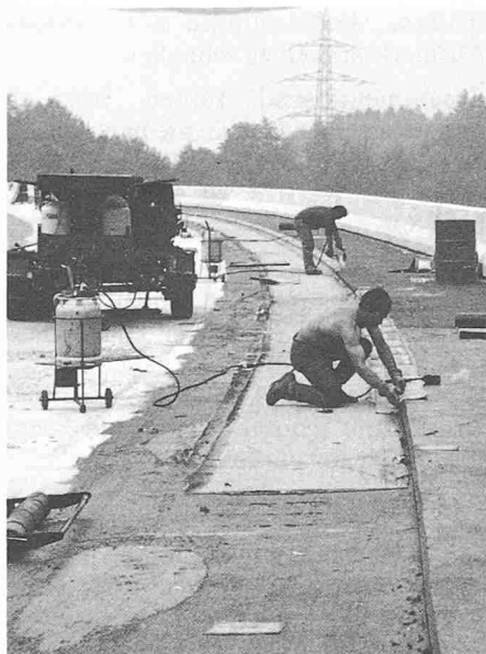
Verlegungsarbeiten der PBD-Bahnen
