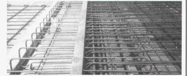
Kragplattenanschlüsse aus Ripinox erhöhen die Sicherheit
