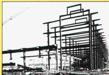
Stahlkonstruktion einer Reparaturwerkstätte für Fahrzeuge im öffentlichen Dienst
