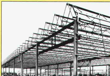
Metallstruktur eines Fabrikgebäudes mit Mini-Sheddach
