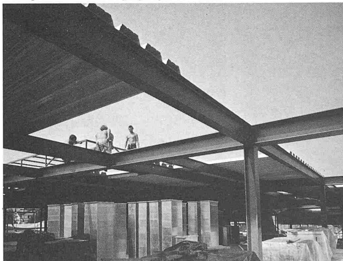
Bild 8. Im Baukastensystem verschraubte Dachträger eines Einkaufszentrums. Montage und Ausbau verlaufen fast parallel
