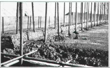
Erstellen einer Anschluss-Dichtung "BFL-MASTIX" Typ 20/70 R4.
