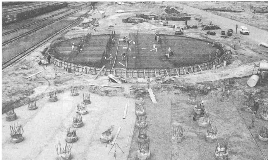
Bild 2. Ausführung von Pfählung und Bodenplatte
