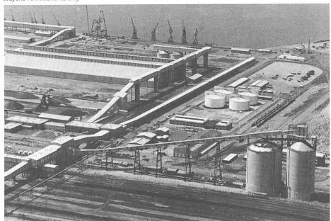
Das Betriebskonzept der Siloauszugsanlagen sieht vor, dass Tonerde und Koks gleichzeitig entnommen und Transportzüge abgefertigt werden können. Die Kapazität der Systeme beträgt 300 t/h für Tonerde und 200 t/h für Koks.
