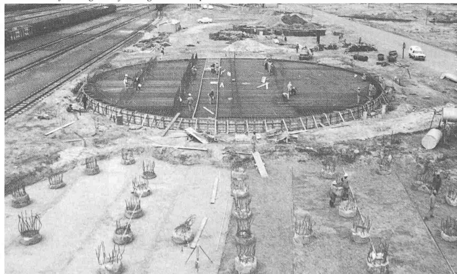
Bild 2. Ausführung von Pfählung und Bodenplatte
