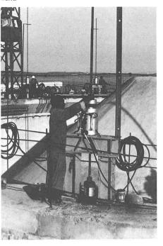
Würfeldruckfestigkeiten nach 28 Tagen waren bei allen drei Silos 52,0 N/mm<sup>2</sup>. Die gemessenen maximalen Abweichungen in den Durchmessern betrugen 21 mm und in der Vertikalen 53 mm. Die maximale Verdrehung war 60 mm.
